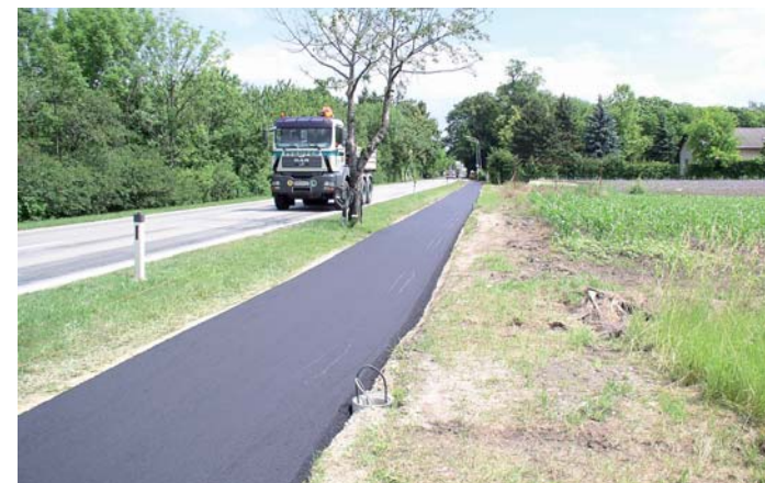
Der neue Radweg in Unterwaltersdorf
