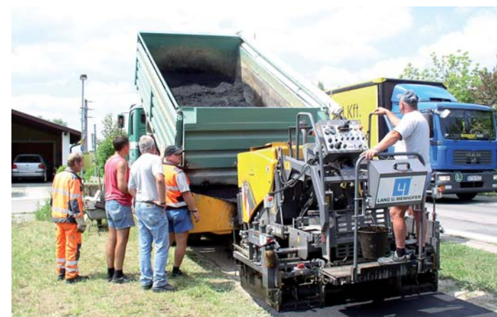
Asphaltierung des Radweges
