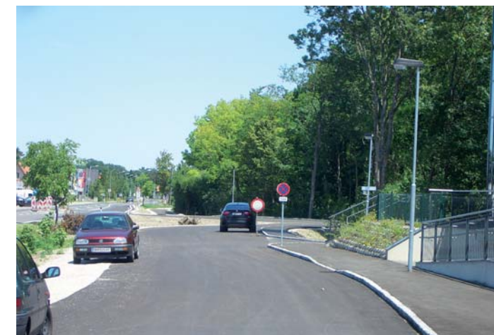
Die neue Zufahrt Kirchberger-Wohnhausanlage in Weigelsdorf
